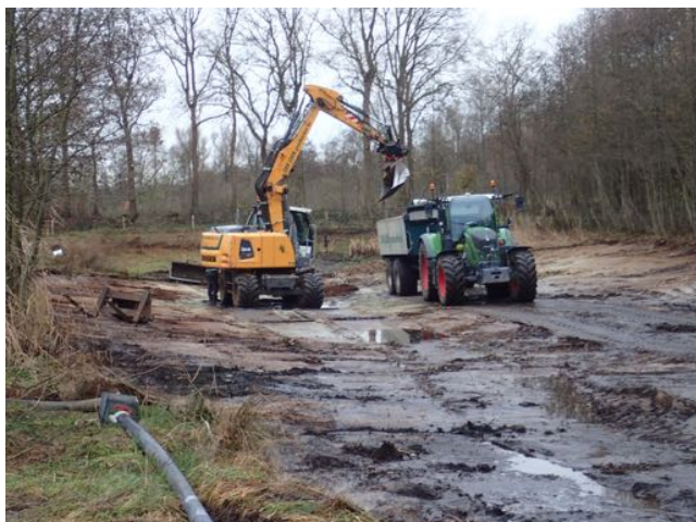
Afb. 12 Werkzaamheden in het Bokkenven 7 december 2021
